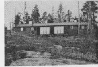
1959 Byggs storstugan på nuvarande lägerbålsplatsen men....
